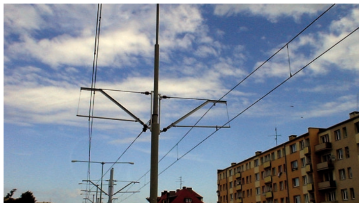
Rys. 10. Nowa sieć trakcyjna w Elblągu
