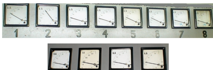
Rys. 23. Sieć kabli powrotnych zaprojektowana nieodpowiednio (góra – nierównomiernie obciążenie) i prawidłowo (dół – równomierne obciążenie)
