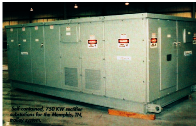
Rys. 14. Prostownik kompaktowy o mocy 750 kW
