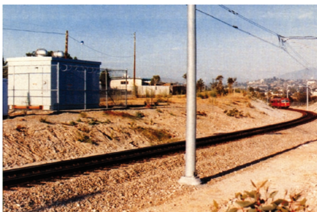
Rys. 13. Podstacja kontenerowa w USA
