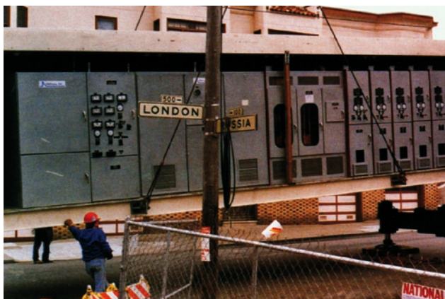
Rys. 12. Przewóz podstacji w Londynie
