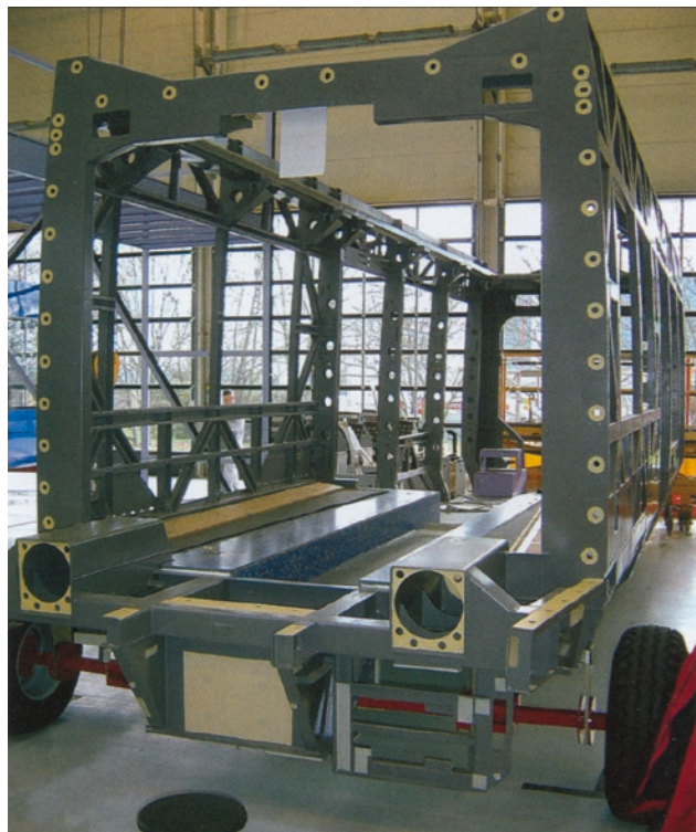
Fot. 15. Budowa Avanto w Duppighei; wagon końcowy
