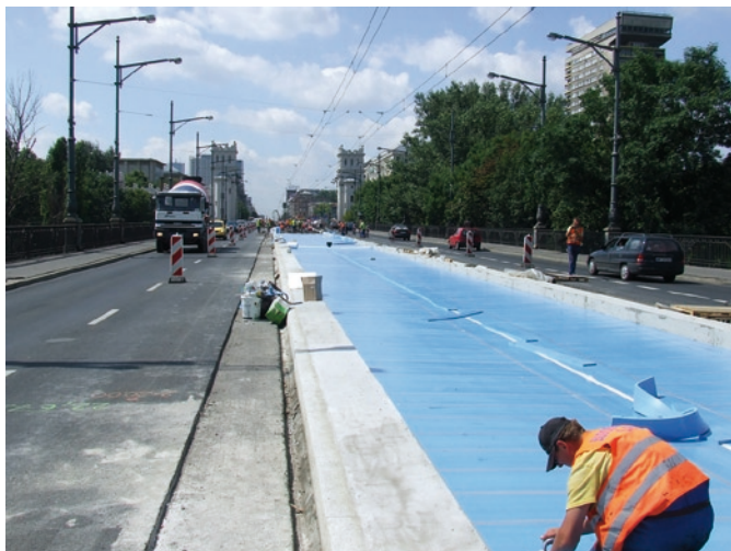
Most Poniatowskiego w Warszawie – zastosowanie mat wibroizolacyjnych w nawierzchni bezpodsypkowej
