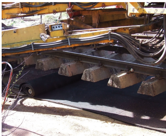
Budowa toru z zastosowaniem maty podtłuczniowej na linii Warszawa – Łódź, odcinek Łódź Widzew – Łódź Andrzejów
