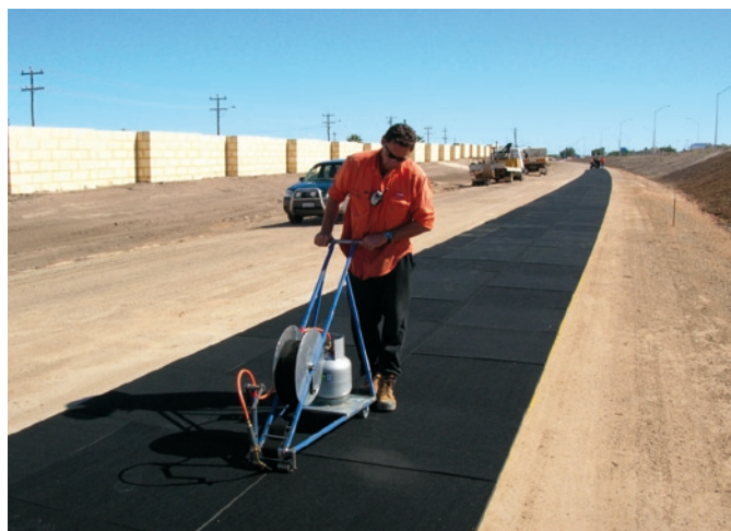
Zastosowanie mat wibroizolacyjnych w torze kolejowym o konstrukcji podсыpkowej
