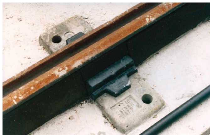
Fot.10. Mocowanie szyny do betonowego koryta
