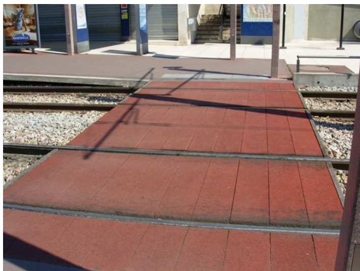
Fot. 4. Linia T2 – nawierzchnia z tartanu na przejściu dla pieszych
