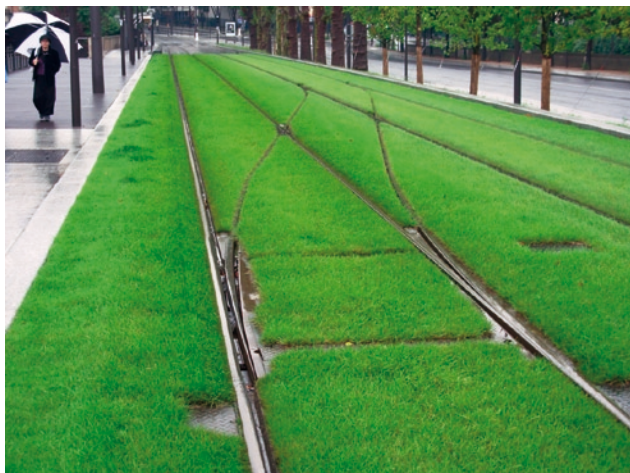
Fot. 11. Linia T3 – jedno z awaryjnych przejść trapezowych na trasie
