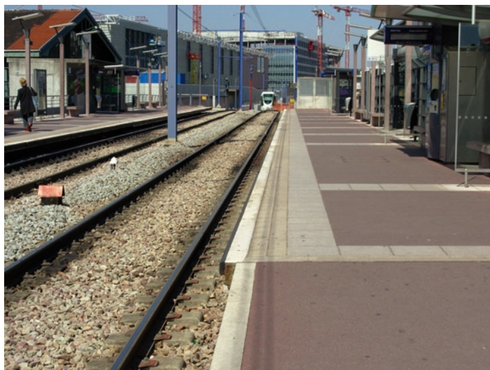
Fot. 3. Linia T2 – przystanek końcowy Issy-val-de-Sienne; od tego przystanku rozpoczęto prace na przedłużeniu linii T2 do Porte de Versailles
