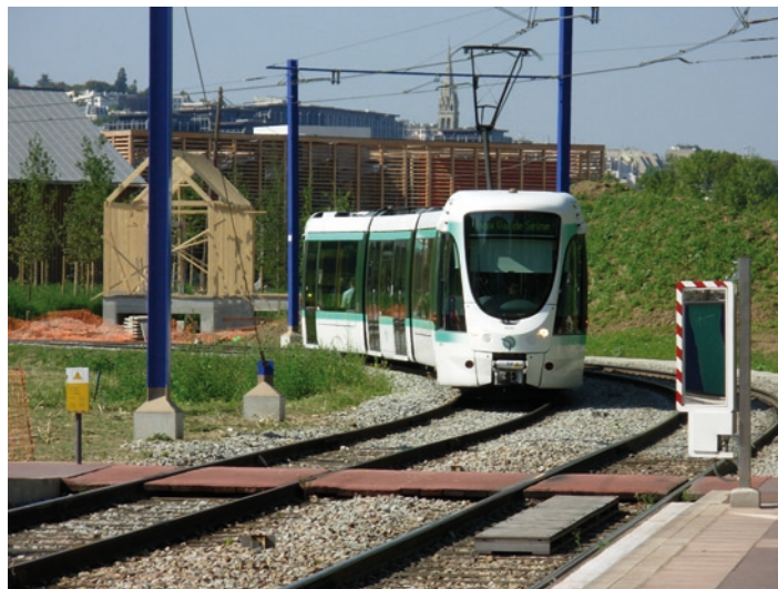
Fot. 6. Linia T2 – Citadis 302 przed przystankiem Ponte de Sevres
