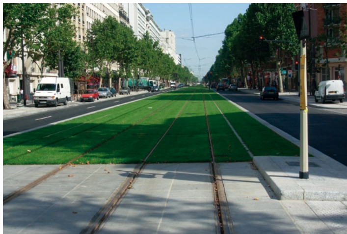
Fot. 7. Linia T3 – torowisko pokryte trawą i przejście dla pieszych z elementów prefabrykowanych
