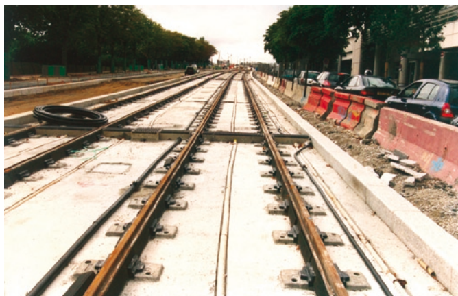
Fot. 9. Budowa torowiskana bulwarze du Gal M. Valin
