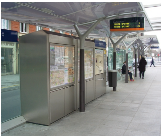
Fot. 12. Linia T3 – typowe wyposażenie przystanku: wiata, panel informacyjny dla pasażerów i automat do sprzedaży biletów; pod daszkiem wiaty jest podwieszony panel z wyświetlaczem informujący o czasie do przyjazdu dwóch najbliższych pociągów
