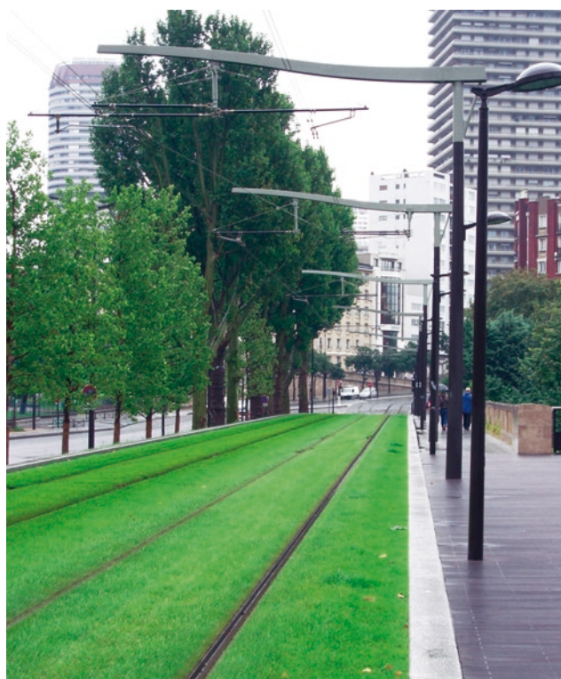
Fot. 8. Linia T3 – sieć trakcyjna dwuprzewodowa (ale nie tańcuchowa) została zawieszona na estetycznych masztach
