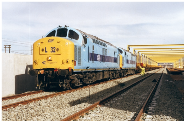
Budowa linii dużych prędkości w okolicy Calatayud, czerwiec 2002 r. – lokomotywa Continental Rail, GIF L-32 (ex BR 37802) Fot. F. Aranda
