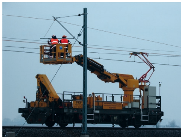
Rys. 11. Pojazd do wpinania liny nośnej i przewodów jezdnych w specjalne uchwyty konstrukcji wsporczej
