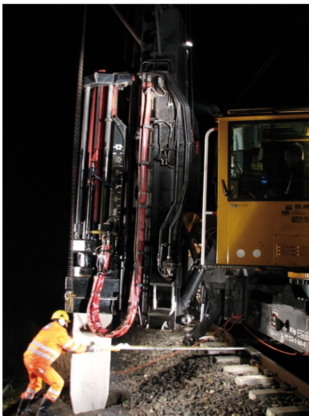
Rys. 6. Wbijanie w podtorze za pomocą palownicy podkładów betonowych przeznaczonych do sadowienia na nich słupów trakcyjnych
