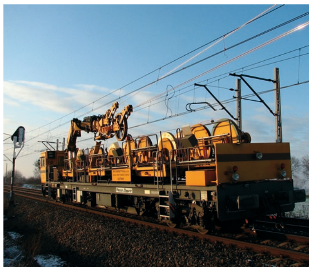
Rys. 8. Rozwieszanie przewodów jezdnych i lin nośnych
