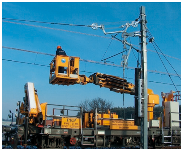
Rys. 7. Proces wywieszania odcinka naprężenia - montowanie i podwieszenie kompletnego, krańcowego urządzenia naprężającego. Wpicie sieci i rozpoczęcie wywieszania, wpinanie liny nośnej i przewodów w uchwyty
