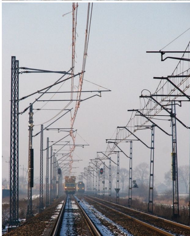
Rys. 12. Rozwieszona nowa sieć
