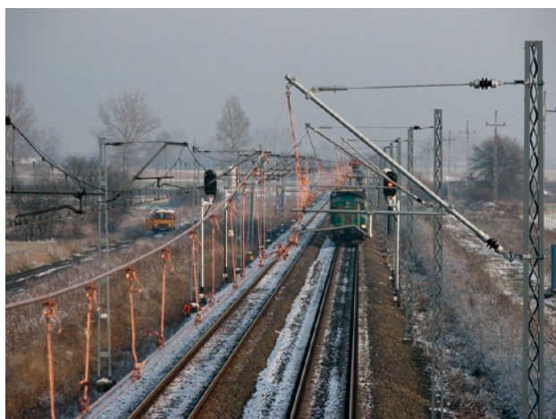
Rys. 11. Pojazd do wpinania liny nośnej i przewodów jezdnych w specjalne uchwyty konstrukcji wsporczej
