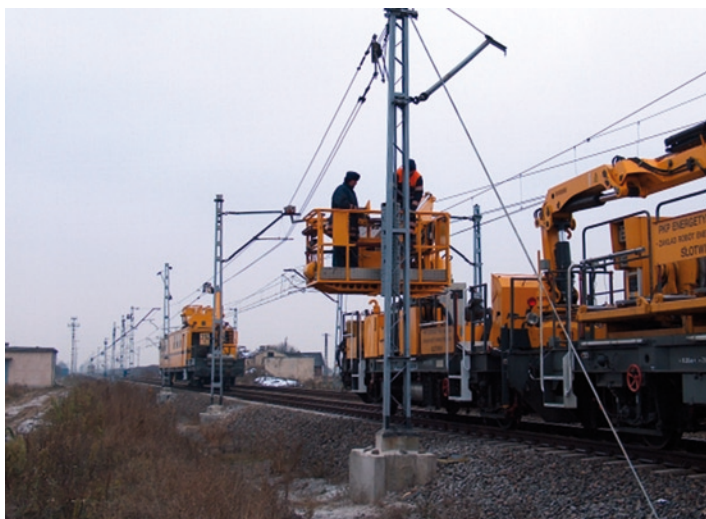
Rys. 5. Przygotowania do demontażu kotwienia krańcowego likwidowanej sekcji, zakotwionej prowizorycznie przez inny pojazd w miejscu oznaczonym strzałką. W głębi widoczny skład dokonujący wstępnego demontażu sieci
