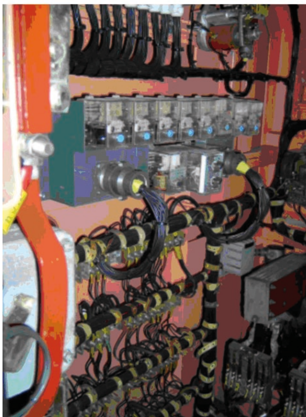
Rys. 18. Wnętrze szafy wysokiego napięcia po naprawie
