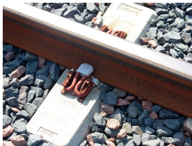
Fot. 2. Od góry: podkłady dwublokowe, podkłady jednoblokowe, sprzężenie przytwierdzenie szyn do podkładu
