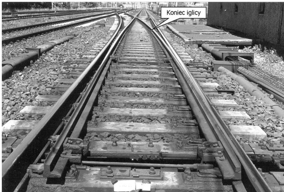
Rys. 9. Rozjazd UIC60-500-1:12
