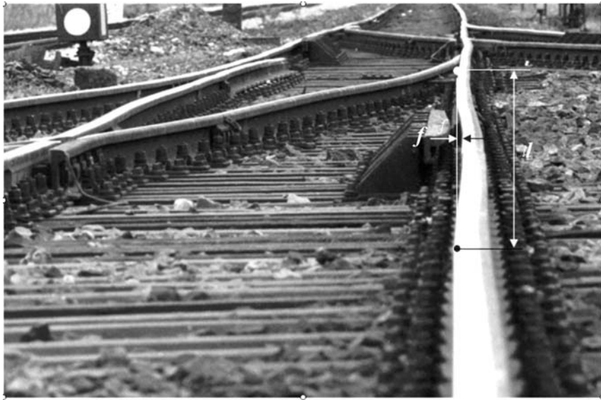
Rys. 2. Zasada pomiaru nierówności toru zasadniczego rozjazdu
