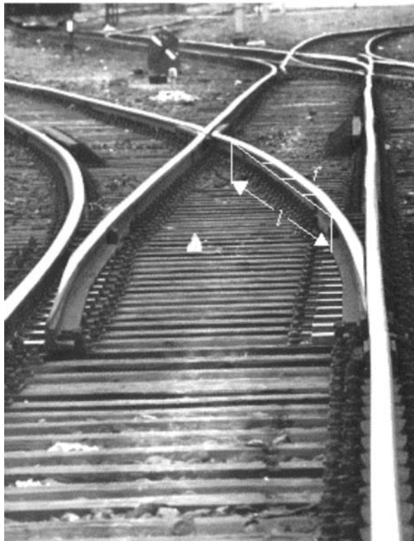
Rys. 3. Zasada pomiaru toru zwrotnego rozjazdu
