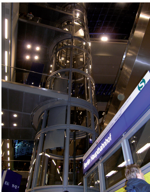
Fot. 13. Jedna z sześciu wind panoramicznych łączących bezpośrednio perony
