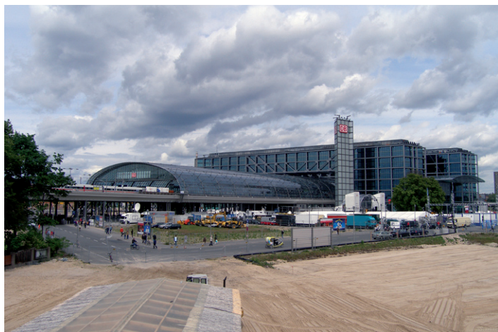
Fot. 7. Widok na dworzec w dniu otwarcia od zachodu, okolice nadal pozostają placem budowy
