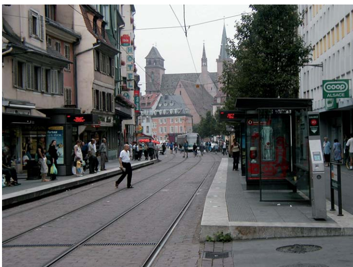
Fot. 1. Strasburg – przystanek na Rue du Fabourg-National w zabytkowym centrum. Perony ze spadkiem na zewnątrz od osi torowiska niwelują stosunkowo wysoką krawędź peronową. Pochylnię zastosowano tylko na jednym końcu Fot. autora (2004)
