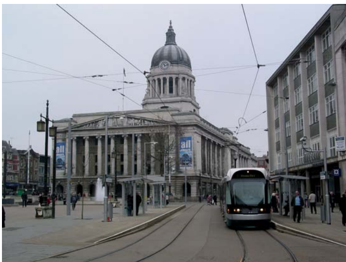
Fot. 2. Nottingham – przystanek tramwajowy na Old Market Square na wprost ratusza. Perony na zewnętrznej krawędzi całkowicie zintegrowane z płytą placu Fot. David Vigar (2004)
