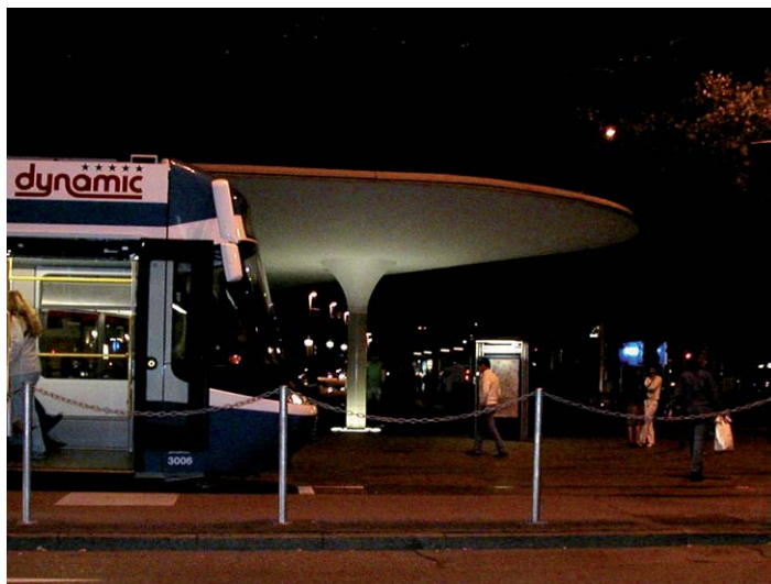
Fot. 7. Zurych – żelbetowa wiata na węźle Belvedere i przód tramwaju Cobra Fot. autora (2004)
