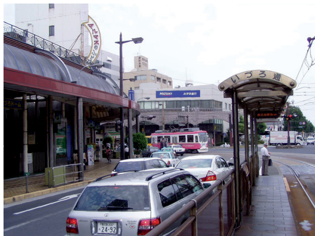
Fot. 7. Kagoshima – przystanek Izurodori w centrum miasta. Wąska wysepka z płytką, wspornikową wiatą to typowe rozwiązanie w miastach japońskich, które zachowały sieć tramwajową
