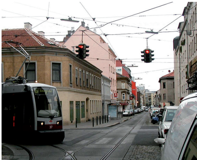
Fot. 31. Wiedeń – Ottakring, Rosensteingasse. Typowy przystanek na wąskiej ulicy z krawężnikiem przysuniętym do toru
