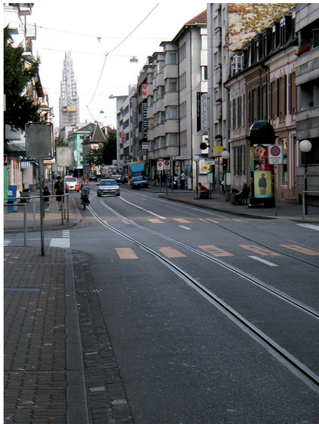
Fot. 34. Bazylea – Güterstrasse. Rozwiązanie kompromisowe: torowisko o rozsuniętych osiach towarzyszą na wpół wysunięte krawężniki
