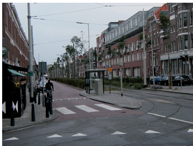
Fot. 30. Rotterdam – Schiedamseweg. Wysypka-peron stanowi kanwę dla meandrowania jezdni i ułożenia progu spowalniającego Fot. autora, 2004
