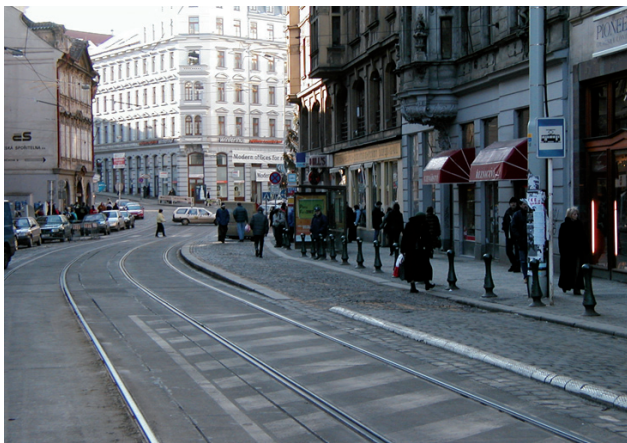
Fot. 35. Praga – Vodičkova ulice. Przystanek z jezdnią wyniesioną ponad torowisko Fot. autora, 2001
