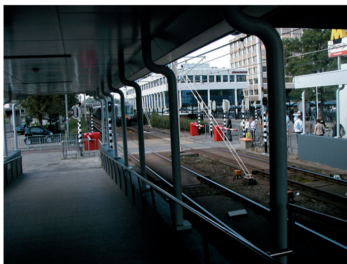
Fot. 15. Rotterdam, stacja metra Alexander. Przejście przez torowisko chronione jest rogatkami. Rampa prowadząca na wysoki peron jest zadaszona Fot. autora, 2004
