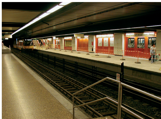
Fot. 3. Stuttgart – stacja Hauptbahnhof (Arnulf-Klett-Platz). Po likwidacji ostatniej linii tradycyjnego tramwaju można wreszcie przystąpić do likwidacji obniżonej części peronu – i, w miarę potrzeby, do wydłużenia składów pociągów Fot. autora, 2003
