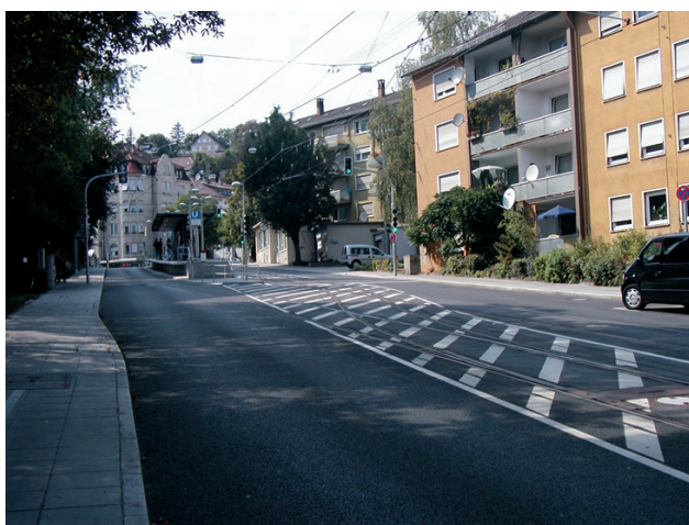
Fot. 37. Stuttgart – przystanek Russische Kirche na Hölderlinstrasse. Wysoki peron wyspowy pośrodku jezdni. Obsługujący przystanek tramwaj zatrzymuje ruch kołowy (tory są w pasach jezdni). Na tym odcinku linia jest jednotorowa, a stacja stanowi mijankę Fot. autora, 2002
