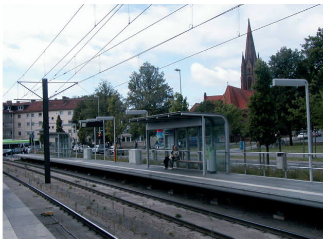
Fot. 1. Hanower, typowy przystanek Stadtbahn (tutaj Krankenhaus Siloah) z parą wysokich peronów bocznych Fot. autora, 2003
