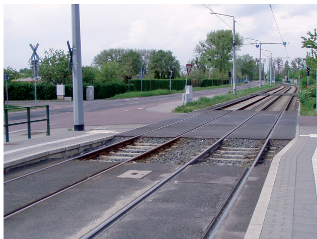
Fot. 21. Dessau – przystanek Kleine Schaftrift na linii do Alten. Strefa buforowa przy przejściu przez torowisko
