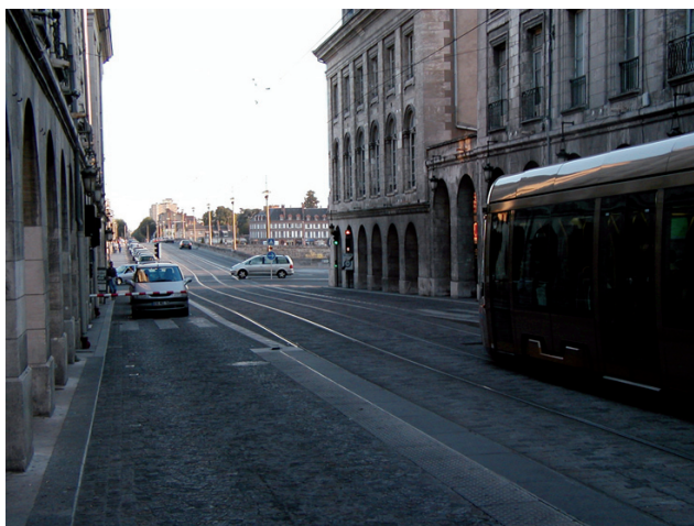
Fot. 23. Orlean, Rue Royale. Przystanek w strefie ruchu uspokojonego, z umieszczonymi naprzeciw siebie jezdniami wyniesionymi na platformy. Tutaj zastosowano rogatki opuszczane przez nadjeżdżający tramwaj. Dla zapewnienia bezpieczeństwa osobom wychodzącym spoza wagonu, a także spod podcieni, rogatki opuszczają się również na przeciwległej jezdni Fot. autora, 2002
