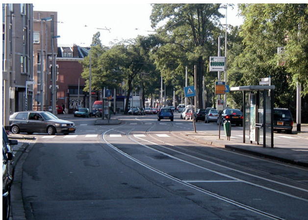
Fot. 27. Rotterdam – Oudedijk. Meandrowanie torów dla wygospodarowania miejsca pod wysypki przystankowe. Kierowcy mijający wysypkę muszą pamiętać o tym, że ruszający tramwaj będzie miał pierwszeństwo Fot. autora, 2004
