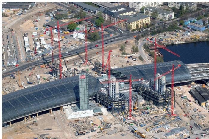
Budowa nowego dworca Berlin Hauptbahnhof
