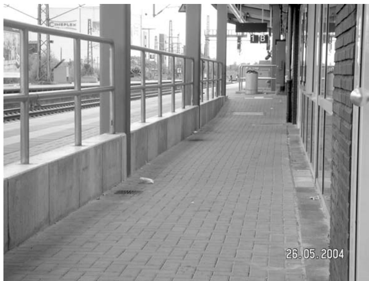
Rys. 20. Przykład zróżnicowania poziomów holu dworca i peronów podwyższonych w efekcie modernizacji na stacji Lippstadt w Niemczech
