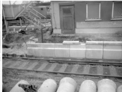
Rys. 6. Peron o wysokości równej 760 mm na modernizowanej stacji Frankfurt na Odrą na linii E20. Po modernizacji dyżurni ruchu mogą korzystać ze specjalnych przejść
