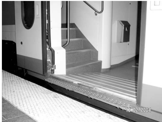
Rys. 45. Bezstopniowe, jednopoziomowe przejście między wagonem piętrowym z progiem podestu na wysokości 600 mm a peronem o wysokości 550 mm
