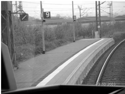
Rys. 7. Rzadko spotykany na liniach zelektryfikowanych w Niemczech nowy peron o wysokości 550 mm, przeznaczony dla francuskich niskopodłogowych, spalinowych wagonów motorowych, kursujących między Strasbourgiem a Offenburgiem
