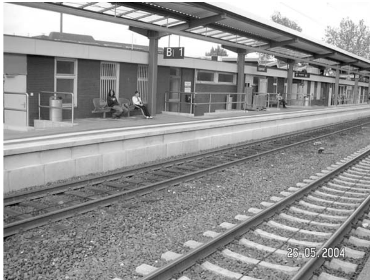
Rys. 19. Lippstadt — niewielka stacja w Niemczech Zachodnich (3 tory główne), przystosowana do przyjmowania trzech w ciągu doby par pociągów ICE poprzez przebudowanie peronów do wysokości 760 mm. Na zdjęciu są widoczne poręcze przy wejściach prowadzących do znajdującego się niżej budynku dworca. Podobny układ torów i peronów pasażerskich ma w Polsce stacja Oława, na której jednak — ze względów inwestycyjnych — rozważane jest pozostawienie peronów o wysokości 300 mm
