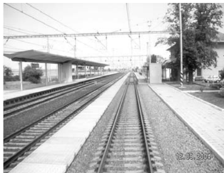
Rys. 4. Typy peronów charakterystyczne dla niewielkich stacji kolei czeskich.
