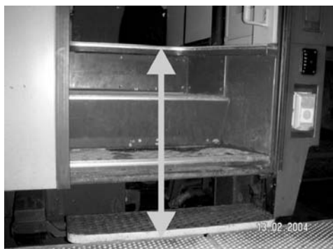
Rys. 30. Całkowita wysokość do pokonania między peronem o wysokości 550 mm a wejściem czteropoziomym wynosi 700 mm (porównaj rys. 22)
