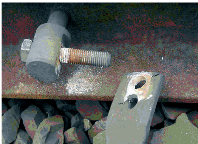
Rys. 11. Połączenie zwiernika z szyną
