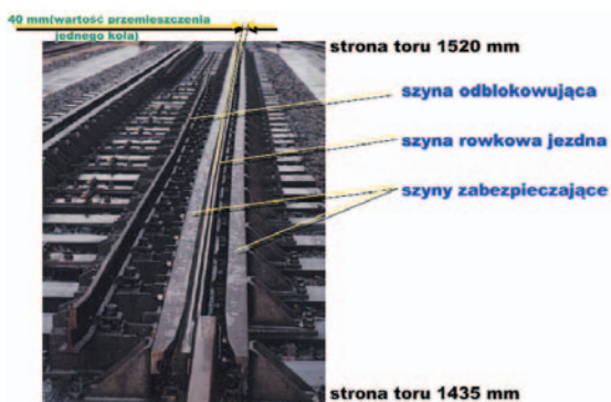
Rys. 8. Wzajemne ułożenie szyn torowego stanowiska przestawczego
