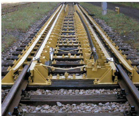
Rys. 7. Torowe stanowisko przestawcze na styku torów 1435/1520 mm na terenie ZNTK Poznań S.A.
