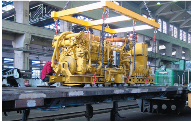
Montaż agregatu prądowórczego na ostoi lokomotywy
