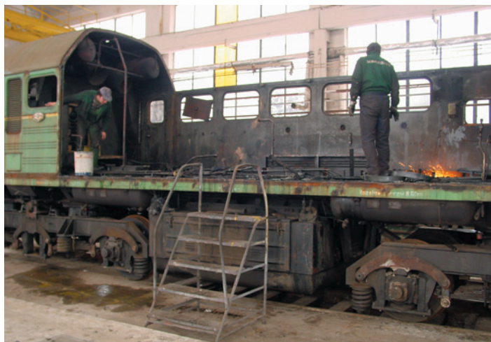
Demontaż lokomotywy ST44
