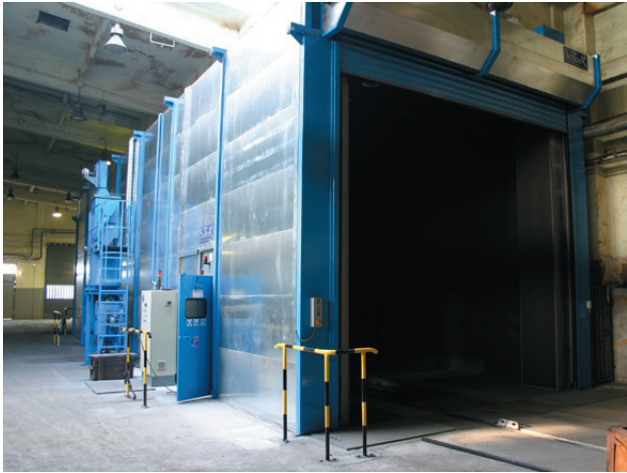
Komora śrutownicza o wymiarach 24×6×6 m
