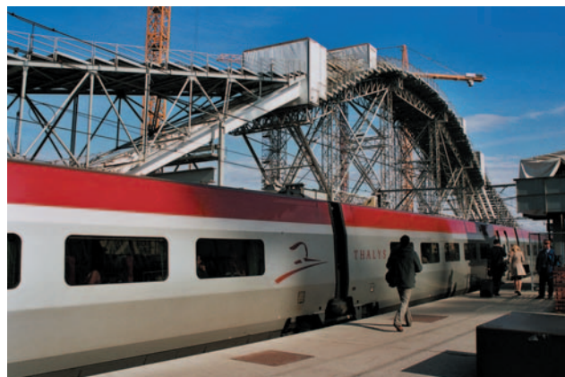
Trwa budowa nowej stacji w Liège i przedłużenia linii dużych prędkości w kierunku granicy niemieckiej
