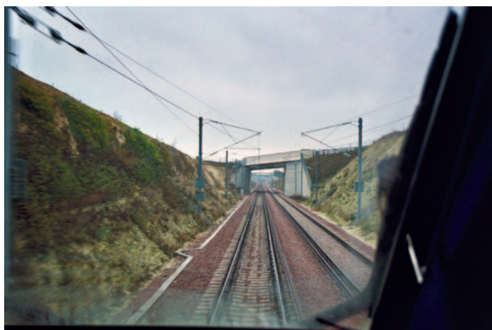
Wjazd na pierwszy, uruchomiony w 2003 r., odcinek linii dużych prędkości między Londynem a Eurotunelem – widoczny początek górnej sieci trakcyjnej i jednocześnie trzecia szyna zasilająca
