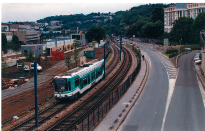
Fot. 4. Linia tramwaju 2 powstała w miejsce linii kolejowej wzdłuż brzegu Sekwany
