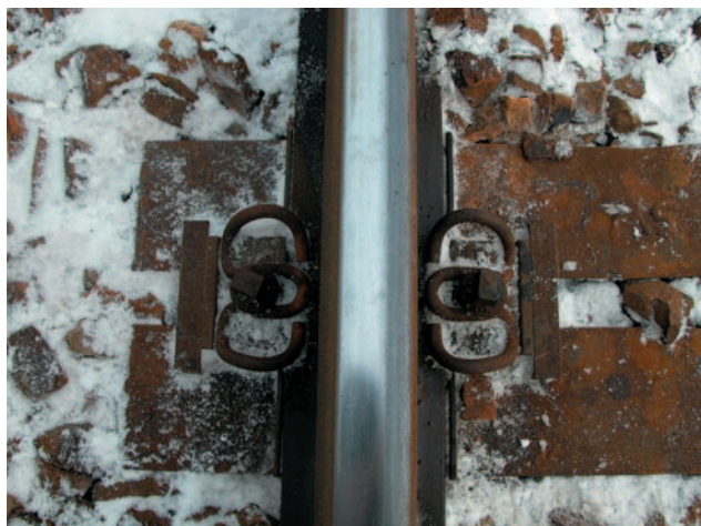
Fot. 2. Widok wybranego przytwierdzenia typu S15
