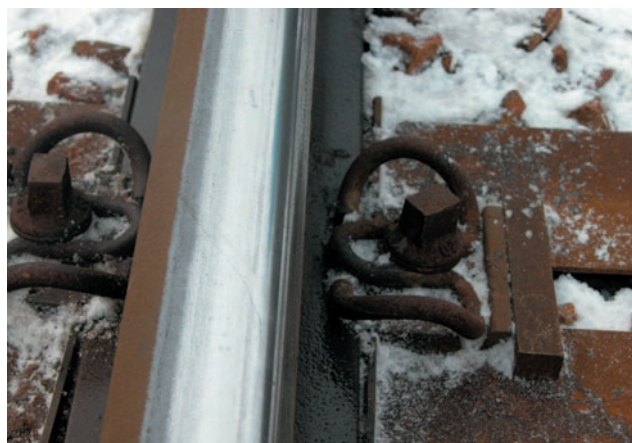
Fot. 1. Widok szyny zewnętrznej na łuku o promieniu 304 m po 12-miesięcznej eksploatacji
