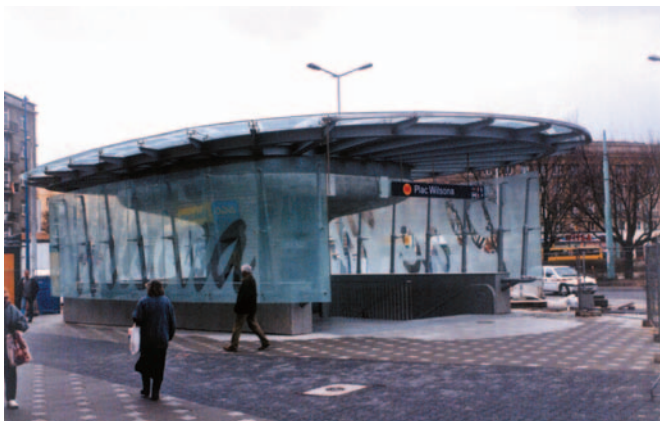
Fot. 4. Szklane wejścia do stacji na placu Wilsona
