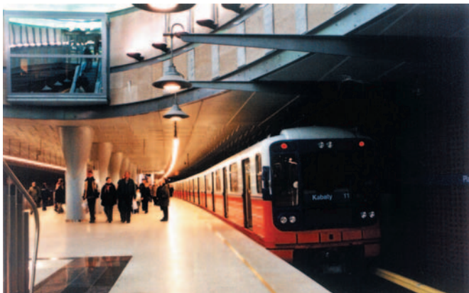
Fot. 3. Za wielkim lustrem umieszczona jest dyspozytornia metra
