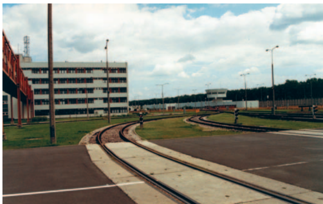
Fot. 5. Stacja Techniczno-Postojowa Kabaty
