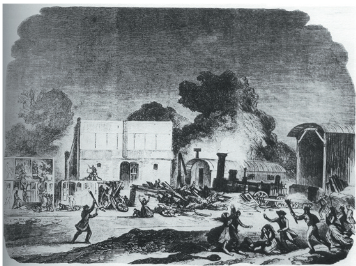
We wrześniu 1858 r. rozpędzony pociąg atmosferyczny staranował lokomotywę oczekującą na stacji Le Pecq, powodując kilka ofiar śmiertelnych; dwa lata później na linii tej kursowały już parowozy Société d'Histoire de Nanterre
