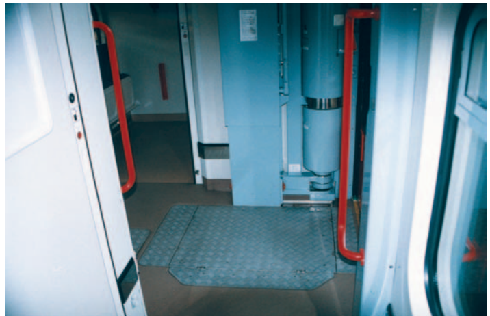
Fot. 9. Wysuwany pomost ułatwiający wejście i wjazd wózków dla osób niepełnosprawnych
