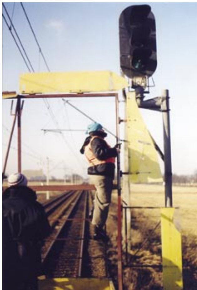
Fot. 3. Użycie skrajnika do pomiaru położenia semafora wjazdowego do Świebodzina na linii CE-20 Źr. Andrzej Etmanowicz
