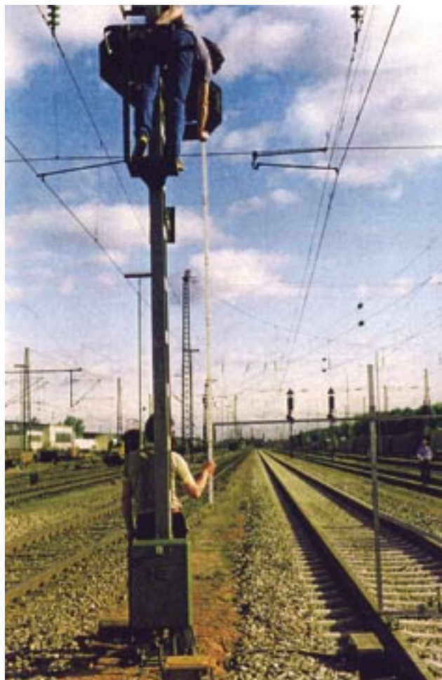
Fot. 1. Ręczna, mało dokładna metoda wykonywania pomiarów ograniczeń skrajniowych na kolejach niemieckich
