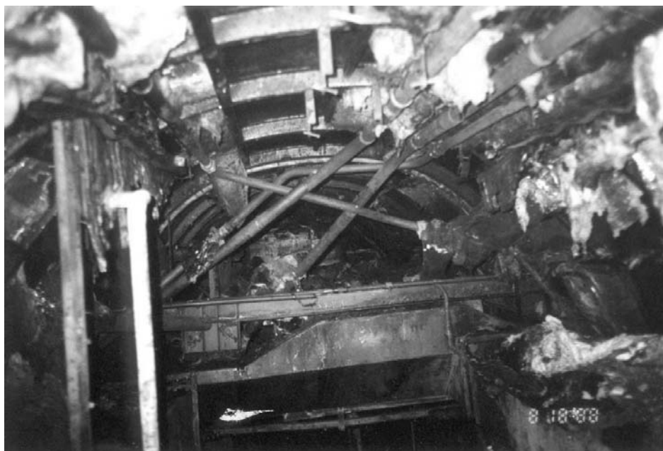
Rys. 7. Spalone wnętrze wagonu – widoczne wypalone wyłożenie sufitu, łącznie z izolacją
