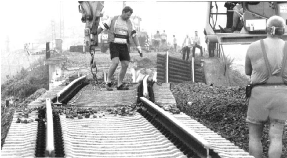
Rys. 9. Usuwanie skutków powodzi w Niemczech. Na pierwszym planie zdejmowanie pręseł torowych za pomocą koparki dwudrogowej
