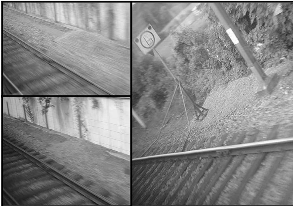
Rys. 6. Przykłady złożonego przy stykach szyn klasycznych hałd gysu wykorzystywanego do podsypywania odmierzonego (SNCB. IX. 2002)
