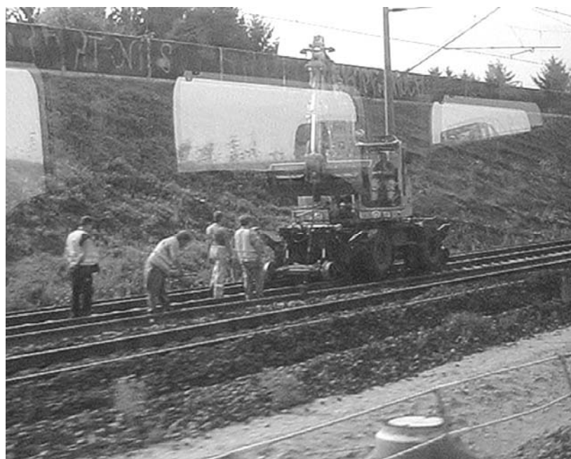
Rys. 8. Koparka dwudrogowa podczas ustawiania długiej szyny do wymiany (Kolonia – Aachen, IX. 2002)
