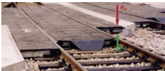
Rys. 6. Wibroizolowany przejazd kolejowy
