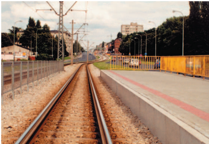
Zmodernizowany odcinek linii z nowym peronem na przystanku Fot. J. Raczyński
