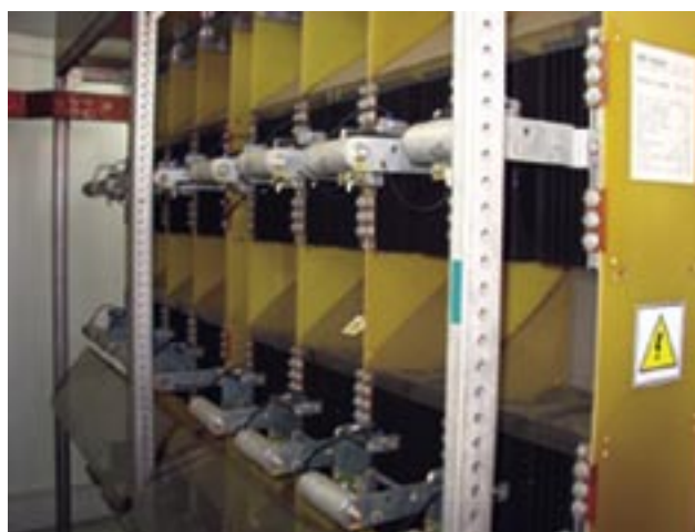
Fot. 6. Fragment prostownika do zespołu typu PD-17 w wykonaniu kontenerowym
