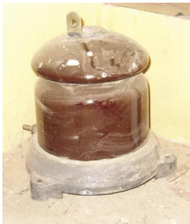
Fot. 11. Odgromnik zaworowy typu GZM 4
