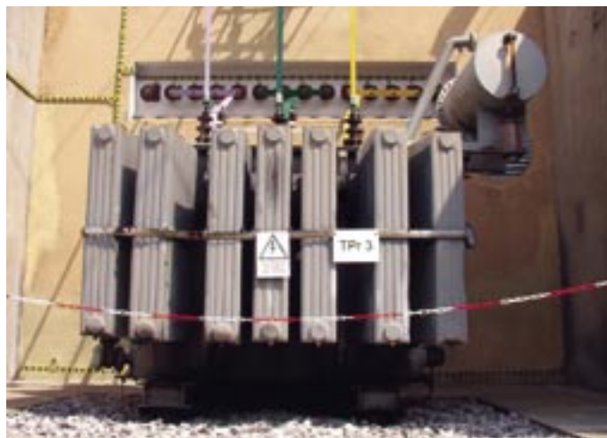
Fot. 1. Transformator prostownikowy zespołu typu PK-17/3,3
