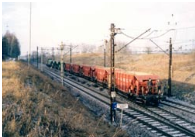
Pociąg roboczy ze szlaku Kunowice – Oderbrücke wraca na stację Kunowice po wyładunku tłucznia na remontowanym torze nr 1
