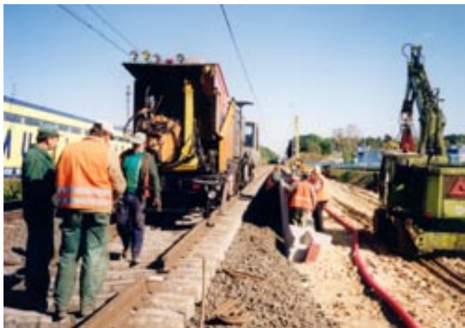
Zgrzewanie oporowe szyn w torze nr 2; na drugim planie widoczna budowa peronu na przystanku osobowym Słubice (km 475,925)
