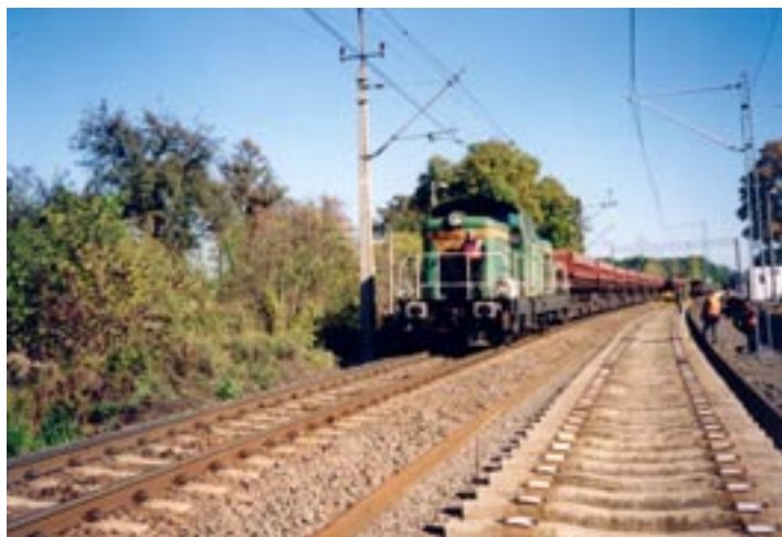
Tor nr 2 w rejonie przejazdu kat. A (km 476,067) na drodze krajowej nr 29 i przystanku osobowego Stubice – po wymianie podtorza i ułożeniu podkładów przygotowano do położenia szyn; widoczne nowe, stalowe słupy sieci trakcyjnej i prowizorycznie podwieszona sieć, na torze nr 1 – pociąg roboczy z kolejnym transportem tłucznia
