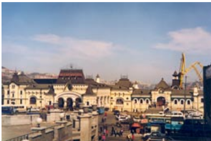
Budynek dworca Władywostok widziany od strony miasta (08.05.2002 r.)
