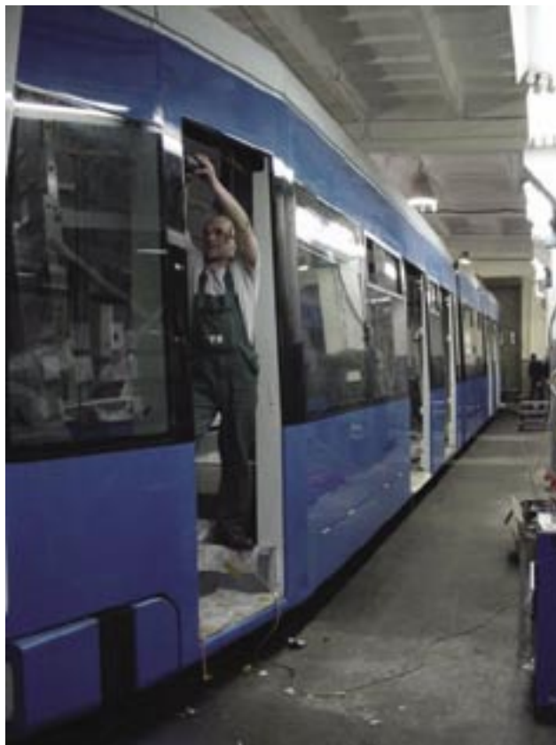
Montaż drzwi – widoczne piąte wejście dla pasażerów, odróżniające zewnętrznie wagony drugiej serii
