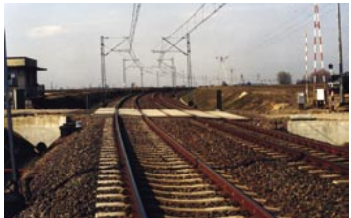
Stacja Słupca i przejazd kolejowy
