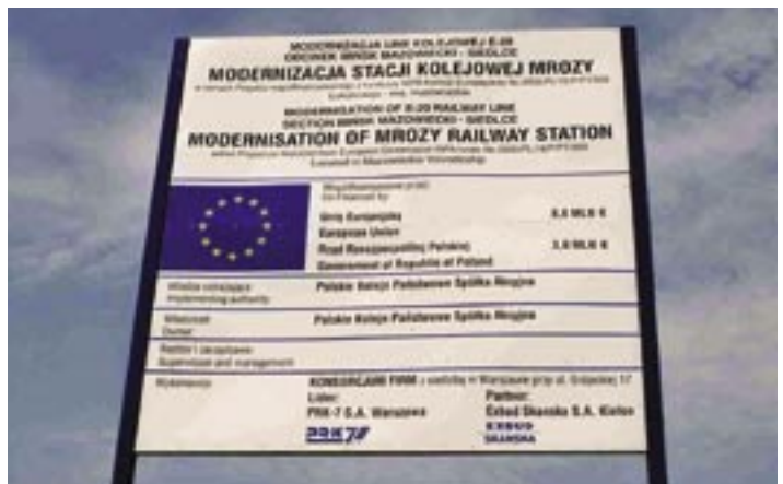
Stacja Mrozy – budowa przejścia podziemnego, nowe przejście rozjazdowe i tablica pamiątkowa
