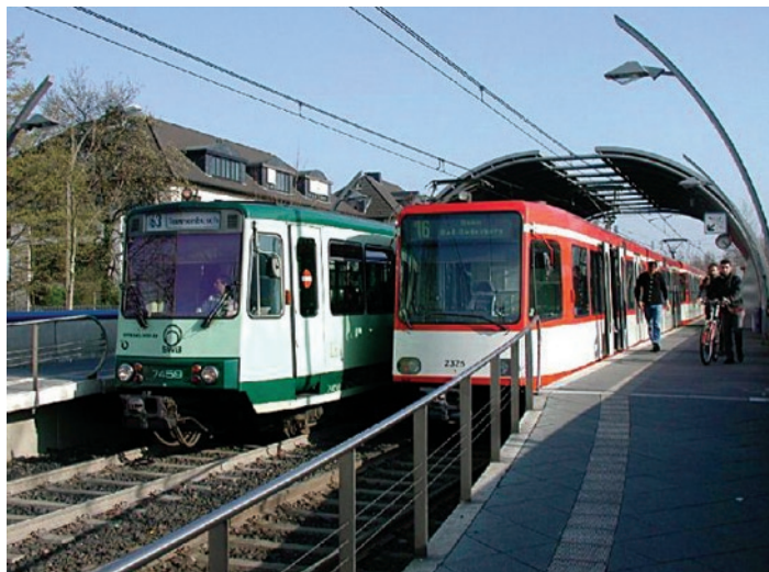
Fot. 12. Bad Godesberg – stacja Hochkreuz/Deutsches Museum Bonn znajduje się na dawnej linii podmiejskiej łączącej Bonn i Bad Godesberg, która od 1978 r. obsługiwana jest także przez pociągi z Kolonii, jadące z Rheinufərbahn; stacja, położona w pasie rozdzielczym ulicy, ma wysokie perony oraz – nietypowo – krótką halę peronową; na zdjęciu tramwaje dwóch przedsiębiorstw: kolońskiego (16) i bońskiego (63) Fot. (c) www.rofrish.de
