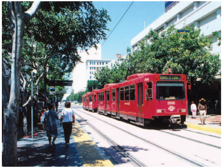
Fot. 19. San Diego – torowisko na 5th Avenue prowadzone jest w jezdni, zwykle z usuniętym ruchem samochodowym; przykład integracji trasy w strukturze centrum miasta, typowy dla amerykańskich tramwajów nowej generacji
