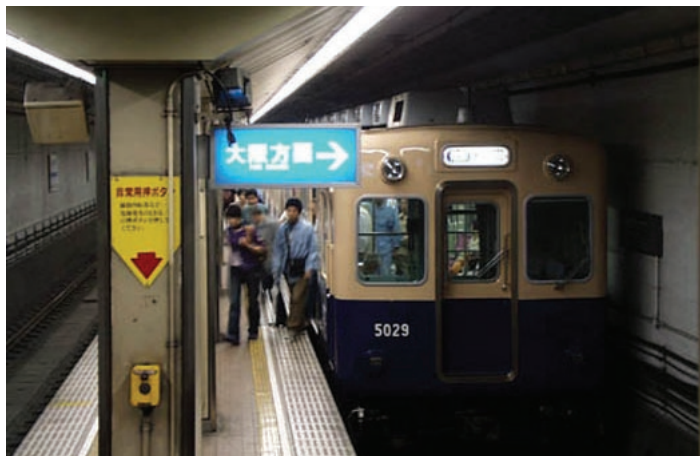
Fot. 15. Kobe – stacja Kasuganomichi kolei Hanshin na podziemnym wjeździe do centrum miasta, zbudowanym jeszcze w 1933 r.; zastawia wąski peron wyspowy – zapewne inwestycja ta, jako finansowana z własnych środków kolei dojazdowej, była robiona „oszczędnościowo”; tunel Kōbe Kōsoku, ze stacjami o parametrach SKM, zaczyna się dopiero dwie stacje dalej (na zdjęciu pociąg kolei Hanshin zmierzający do dworca Hanshin-Umeda w północnym centrum Osaki) Fot. (C) Takeshi Tomiyoshi, 1998
