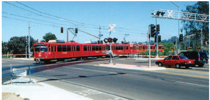
Fot. 20. San Diego – linia tramwajowa poza śródmieściem, na północnej gałęzi Blue Line, koło stacji Morena/Linda Vista (ten odcinek nie jest wykorzystywany przez pociągi towarowe); przejazdy przez ulice są zwykle zaopatrzone w sygnalizację, tutaj dodatkowo zastosowano rogatki; tramwaj przejeżdża tą trasą średnio co 7,5 min (na zdjęciu najczęściej spotykany skład, złożony z trzech jednostek dwuczłonowych – tutaj typu U2)
