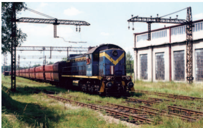
TEM2-088 z KP Kotlarnia ze składem talbotów na stacji Pyskowice; widoczne słupy trakcyjne bez sieci, która częściowo została skradziona, a częściowo rozebrana, rok później zdemontowano również słupy trakcyjne (06.07.2001)
