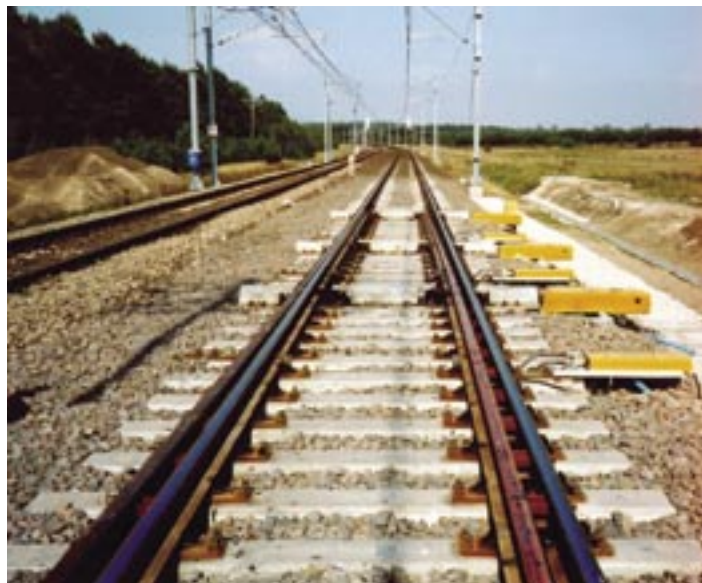
Fot. 1. Zwrotnica rozjazdu produkcji KolTram typu UIC60-1:18.5-1200, stacja Psary Fot. D. Korab
