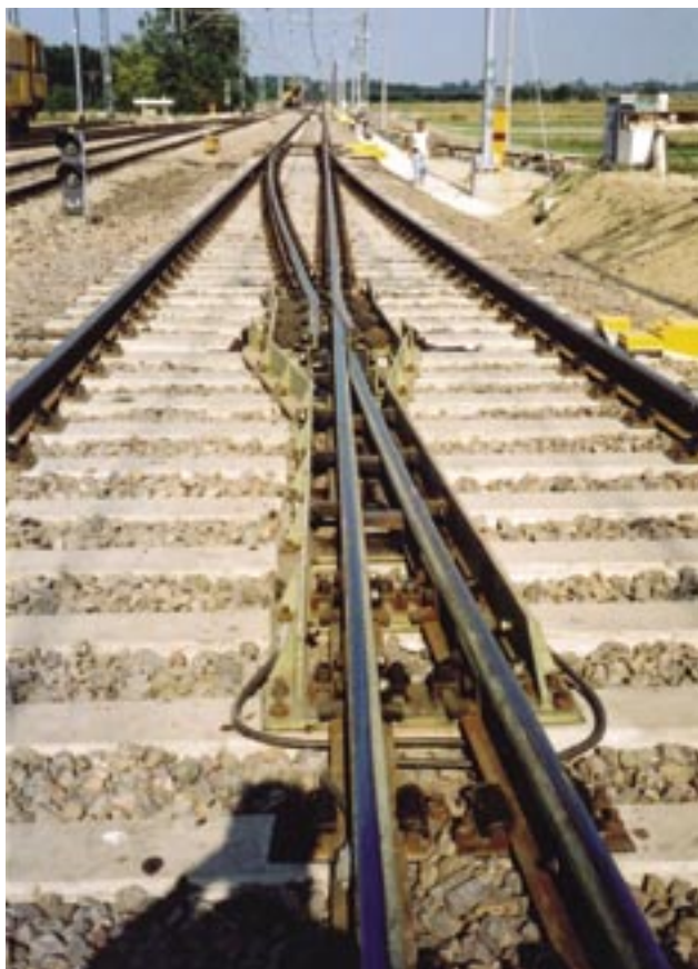
Rys. 3. Rozjazd firmy VAE AG typu UIC60-1:12-500, stacja Psary
