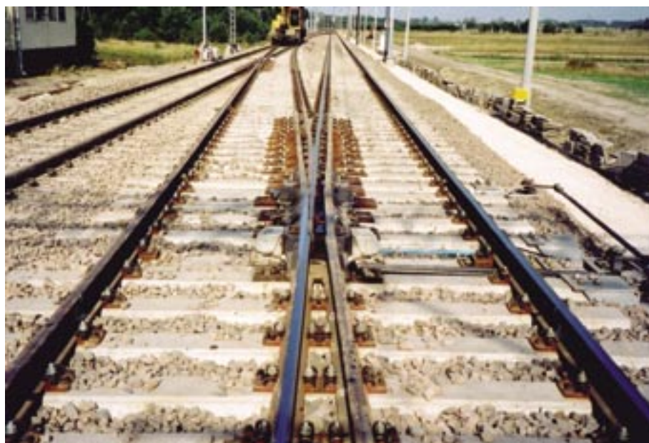
Fot. 5. Krzyżownica rozjazdu typu UIC60-1:18,5-1200 produkcji COGIFER na stacji Psary Fot. D. Korab
