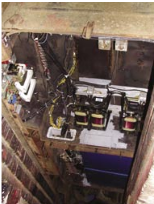
Rys. 2. Skrzynia aparatu z zabudowanym obwodem wejściowym typu ENI-OWE/200
