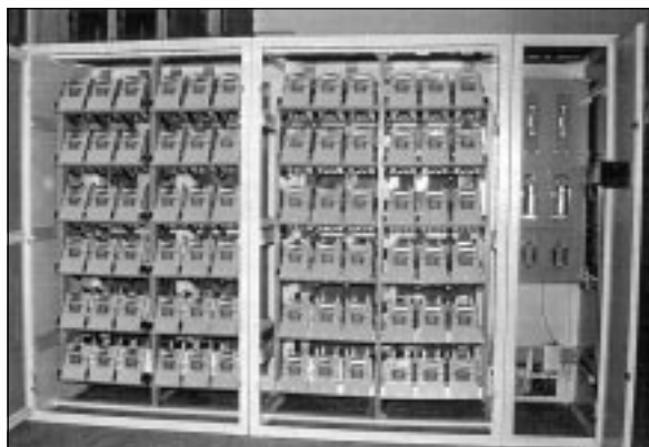
Rys. 1. Prostownik diodowy 1700 A, 3300 V dla podstacji trakcyjnej z jednostopniową transformacją napięcia 110 kV AC/3 kV DC
