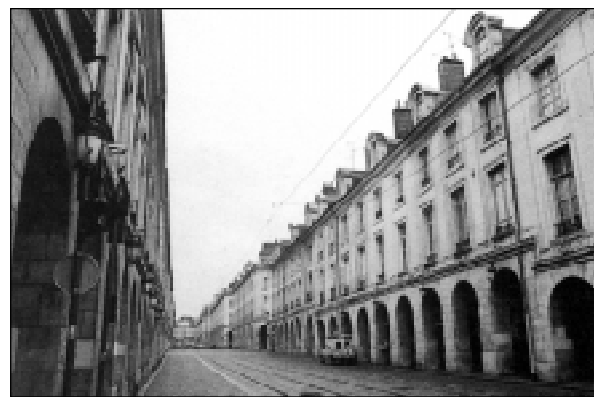
Fot. 4. Dyskretnie zawieszona i odpowiednio napięta pojedynczy przewody jezdne na Rue Royale w Orleanie
