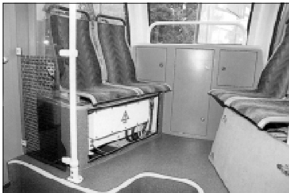
Fot. 7. Rostock – 4NBWE, przetwornica pokładowa firmy Kiepe
