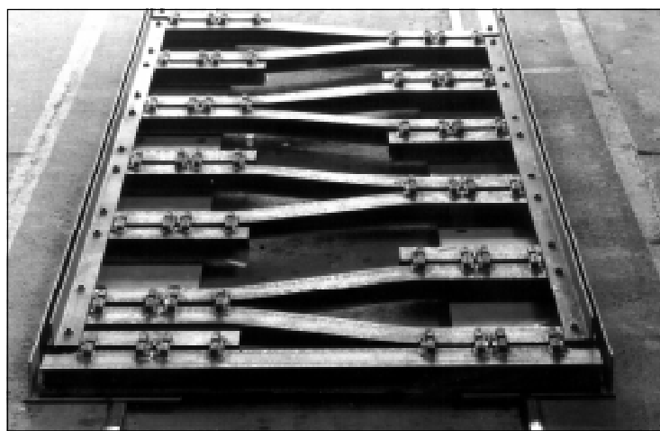
Rys. 11. Podkłady stalowe typu Y przeznaczone na most bez podsypki [3]
