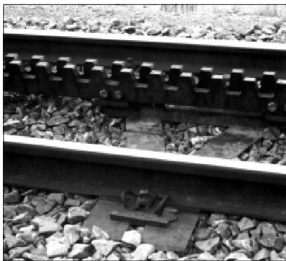
Rys. 9. Podkłady stalowe typu Y kolei zębatej Oberralpbahn (Szwajcaria) [3]
