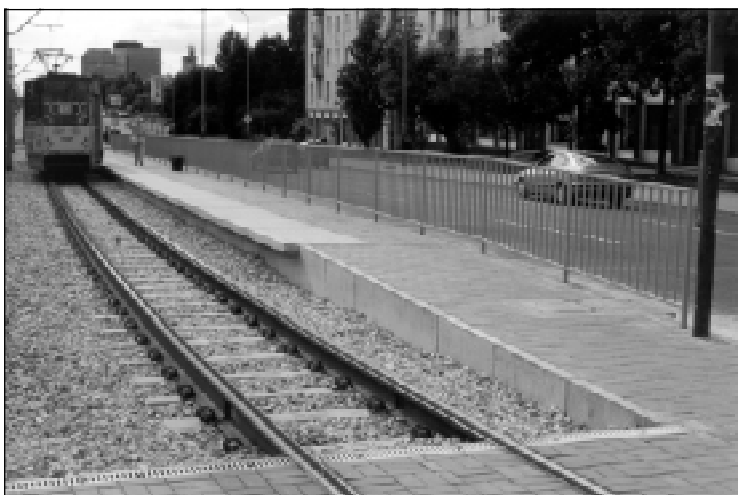
Peron na zmodernizowanym odcinku trasy
