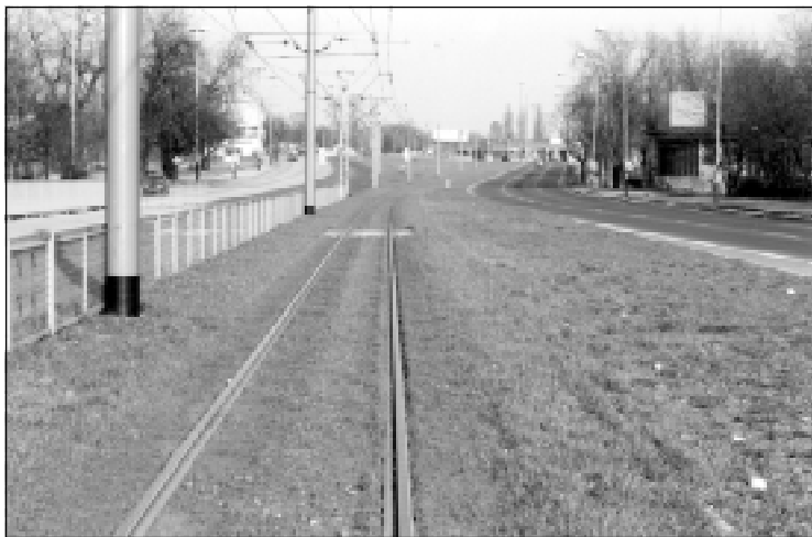
Fragment trasy z torom wyłożonym trawiastą murawą
