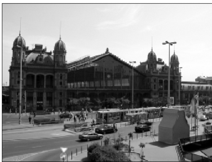
Budapeszt – Dworzec Nyugati. Typowe powiązanie dworca, przystanków tramwajowych i stacji metra przy pomocy podziemnego westybulu. Przejście w poziomie jezdni urządzone niedawno na drugim końcu wysepek przystankowych Fot. J. Wesołowski, 2002
