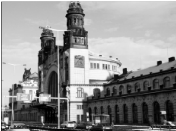
Praga – Dworzec Hlavní. Unikatowa secesyjna budowla odcięta została trasą szybkiego ruchu i – jak dotąd – nie znajduje odpowiedniego wykorzystania Fot. J. Wesołowski, 2001
