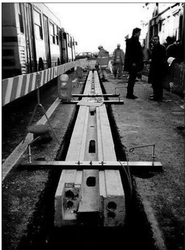
Rys. 2. Zakładanie sieci zasilającej
