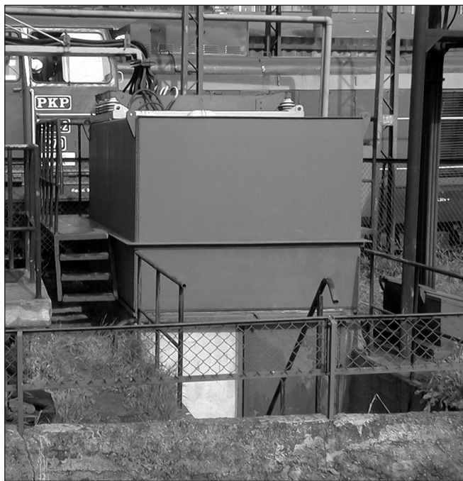
Fot. 1. Widok opornika wodnego
