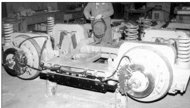
Fot. 24. Podwozie członu przegubowego pojazdu dla Gdańska i Katowic z centralnym mocowaniem przegubu Fot. Alstom
