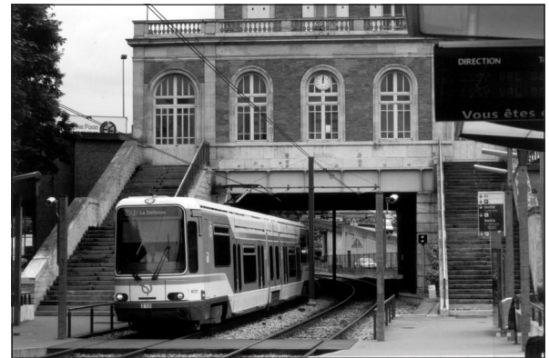
Przystanek linii T2 w miejscu historycznego dworca kolejowego w mieście Sevrés
