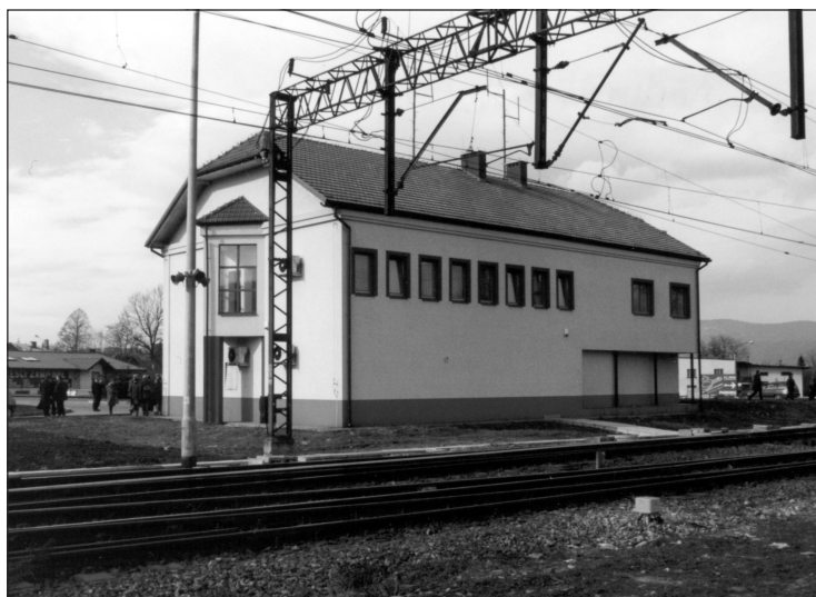
Fot. 2. Nowy budynek nastawni elektronicznej w Żywcu
