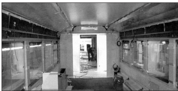
Rys. 7. Wagon typu B podczas przebudowy wnętrza
