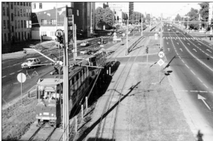
Trasa tramwajowa, oddana do eksploatacji ponad 21 lat temu i przecinająca centrum miasta w osi wschód–zachód, jest obecnie poddawana modernizacji. Za kilka lat będzie to trasa szybkiego tramwaju miejskiego
