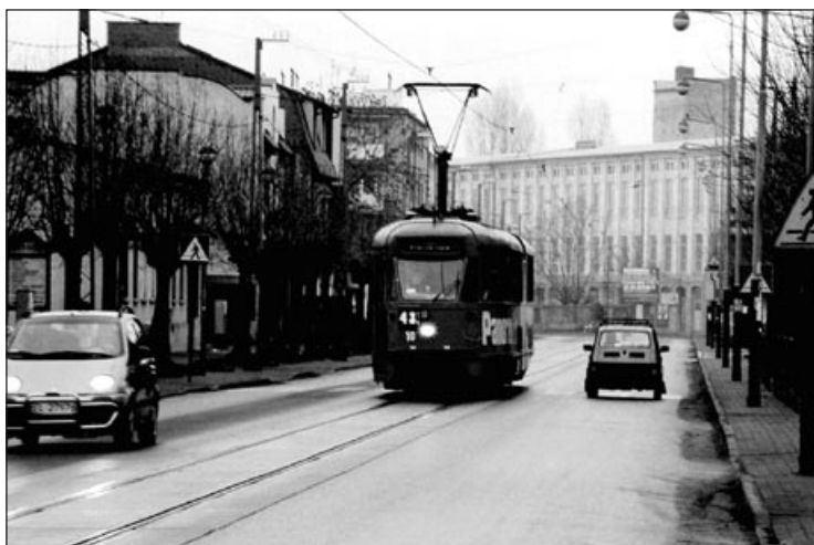
Miasto Konstantynów w ramach remontu ulic modernizuje również torowiska tramwajowe
